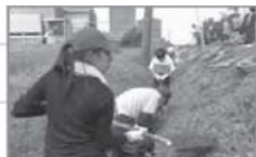
水路の泥出し
